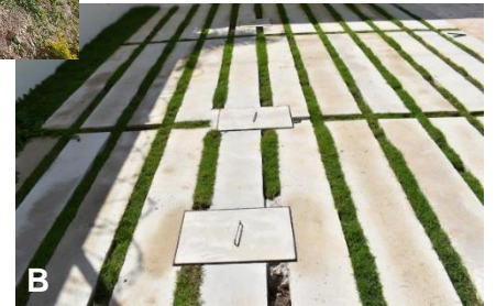
Figura 3. Sistema Individual de Tratamiento de Agua Residual (SITAR DLD14®) construido en panel estructural sin loza (A) en áreas verdes y con loza de seguridad (B) en zona de estacionamiento.
