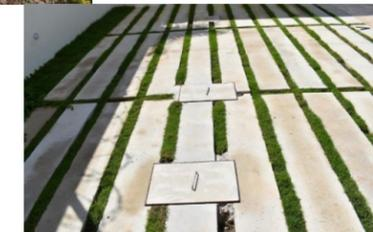
Figura 3. Sistema Individual de Tratamiento de Agua Residual (SITAR DLD14®) construido en panel estructural sin losa (A) en áreas verdes y con losa de seguridad (B) en zona de estacionamiento. NOTA: Todos los sistemas construidos en obra requieren una plantilla de concreto para su nivelación, con un espesor mínimo de 15cm.
